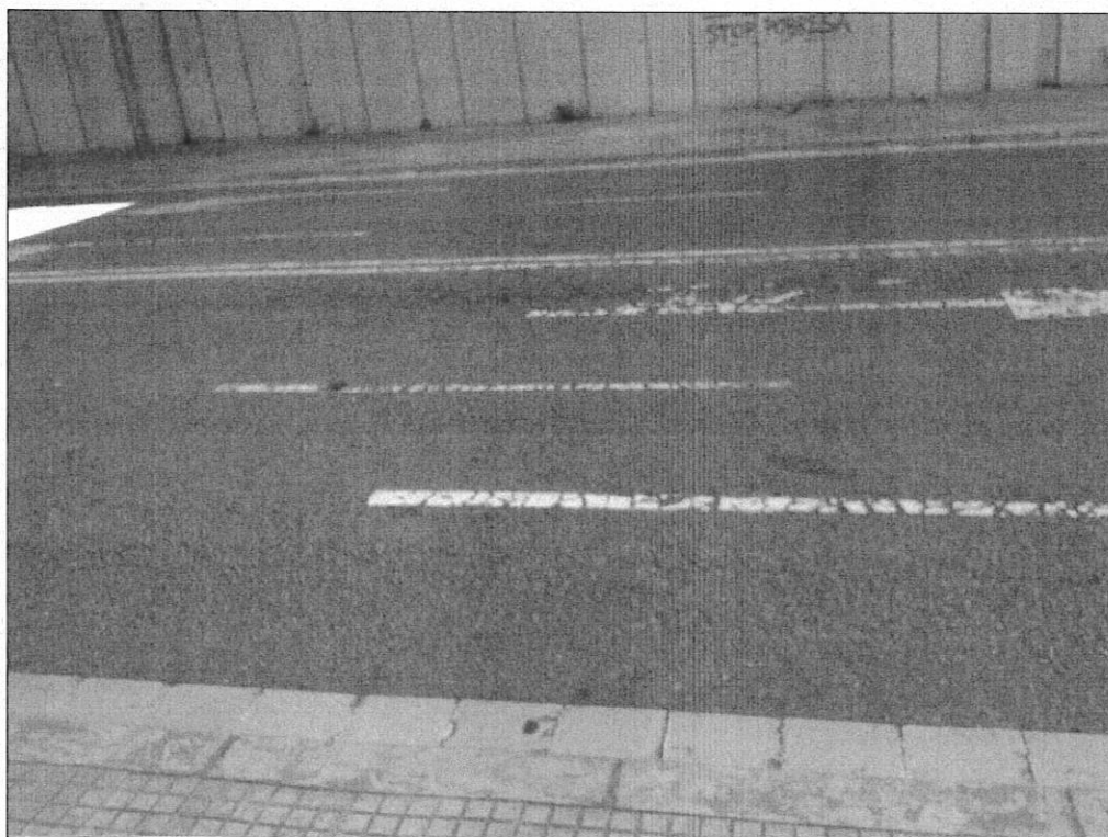
Av. Martí Pujol sota pont autopista B-20
