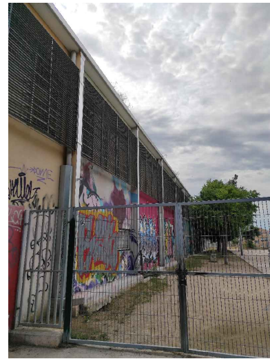
Fotografia façana lateral
