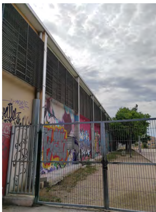
Bufalà – Façana lateral
