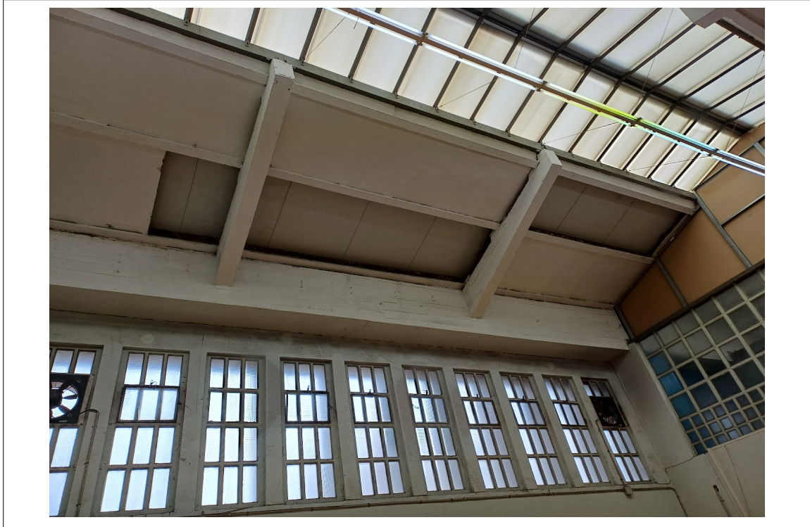
Zona del Sostre del gimnàs a reparar
