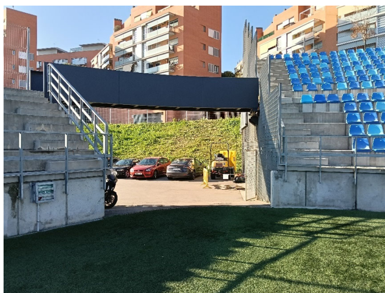
Accés al terreny de joc
