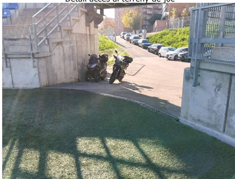
Detall accés al terreny de joc
