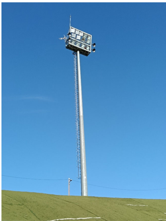
Substitució lluminàries de les 4 torres d'il·luminació existents per nous focus LEDs
