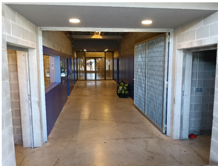
Túnel de jugadors, planta soterrani -2. Vista cap a l'interior
