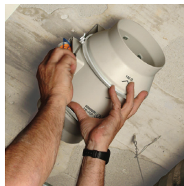
Colocar el cuerpo motor.
