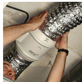
Acoplar los conductos.
