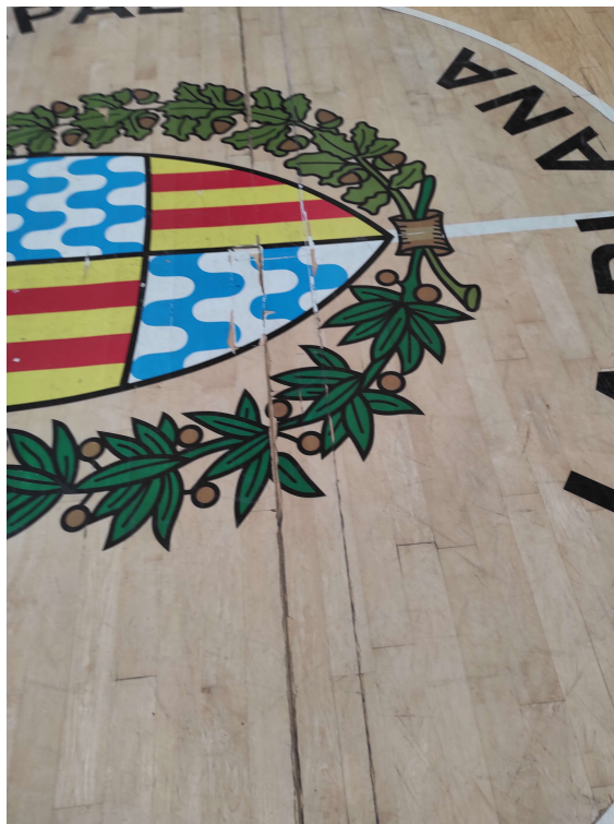
La Plana – Estat parquet actual
