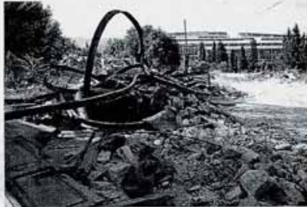
Estat en què ha quedat la casa dels jardiners, on avui s'ha embarracat. / 02
