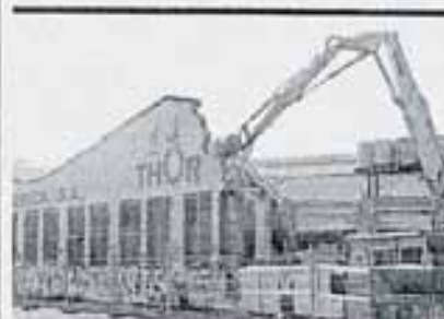
► Enderroc a Montsolió. Una màquina ha treballat aquests dies en l'enderroc d'una de les fàbriques del poble de Montsolió, a Sant Adrià de Besos. Es tracta de l'edifici de l'antiga nau de l'empresa d'electrodomèstics Thor Ibèrica, que estava situada a la cruïlla de carrers Joan d'Àustria i Almirall Oquendo. / G.A.
